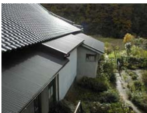
改修後の裏屋根
