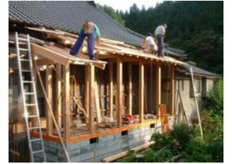
物置工事棟上風景
