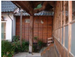
渡り廊下補強修理
