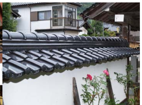
③山門脇塀瓦交換
