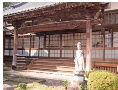
改修後の本堂正面側
